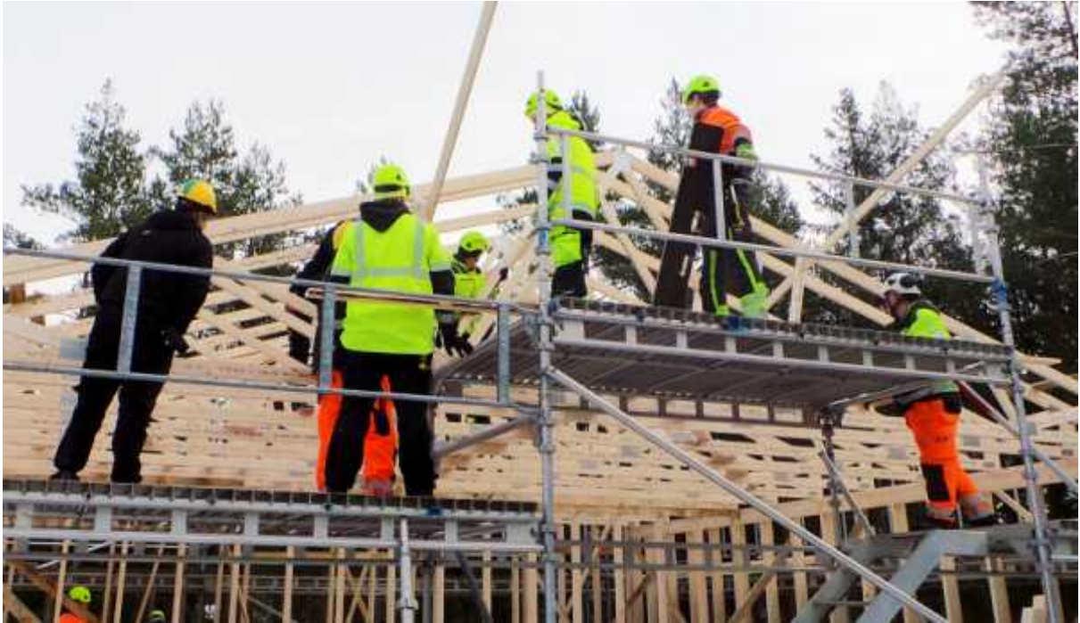
Rakennustyömaat ovat opiskelijoille tärkeä oppimisympäristö.
